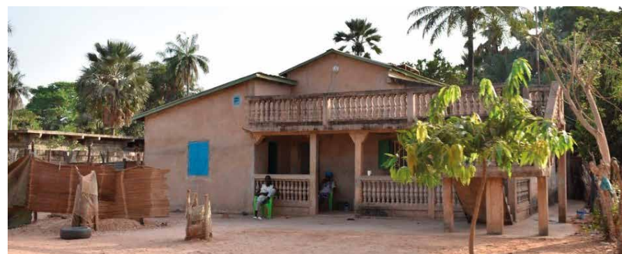
Foto 47 - Casa de tipo “moderno” com um andar, construída pela diáspora, com estrutura de betão, janelas dobráveis com abertura para o exterior e uma saída de ventilação
