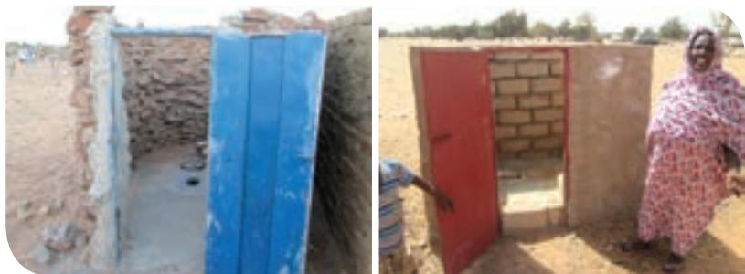
Les latrines améliorées à fosse unique peuvent être recouvertes de dalles SanPlat. Il existe deux types de dalle SanPlat : la dalle carrée et ferrillée et la dalle ronde non ferrillée. Dans les deux cas, le trou de défécation est muni d'un couvercle pour empêcher l'accès des mouches.
