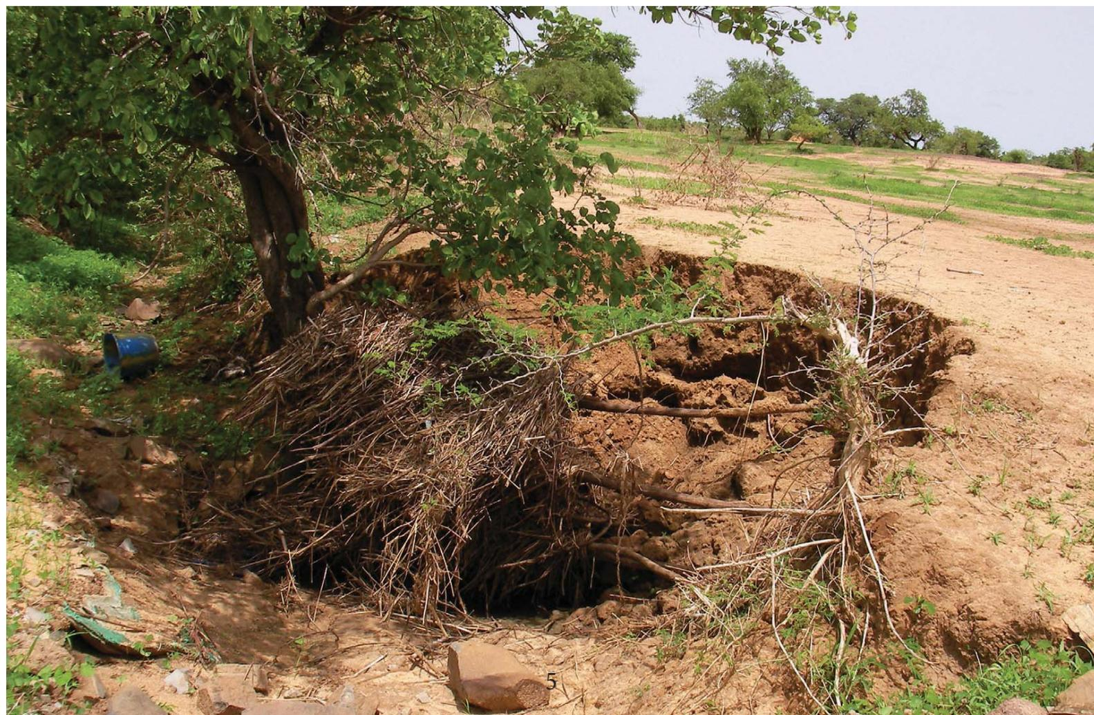
ouvrages n'est pas adaptée techniquement provoquant des phénomènes d'érosion régressive déstabilisant les ouvrages.
